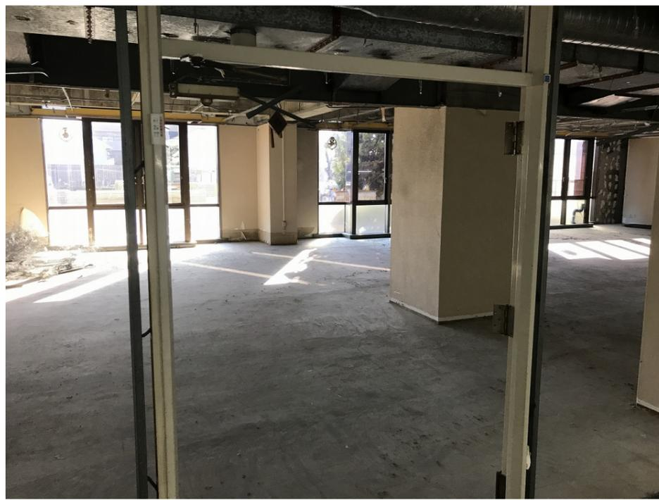
内部アスベスト撤去完了（詰所）
