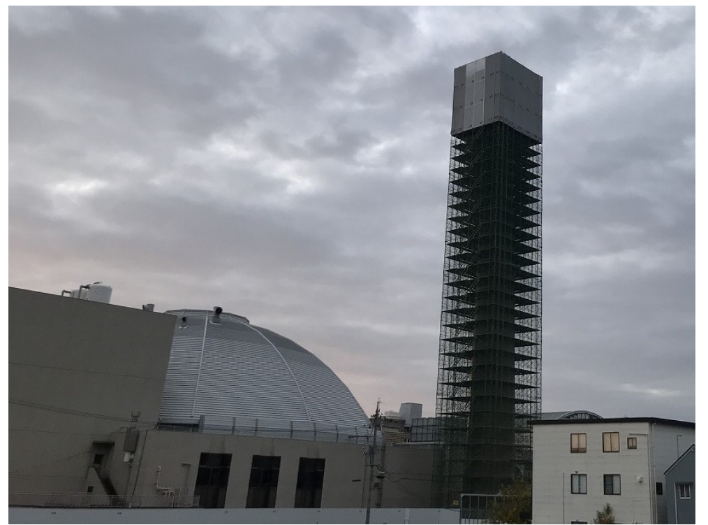
煙突足場組立完了
