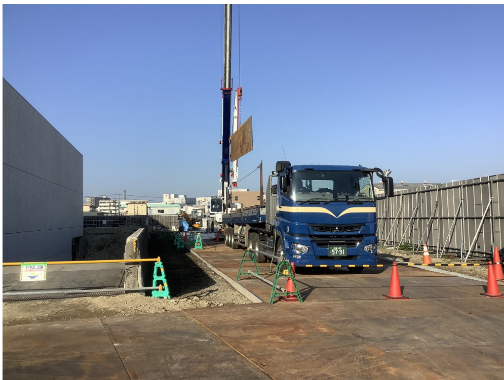
現場内鉄板敷き設
