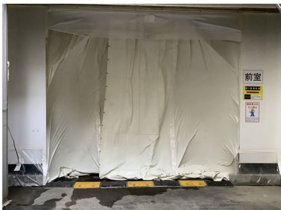
除染工事設備設置
