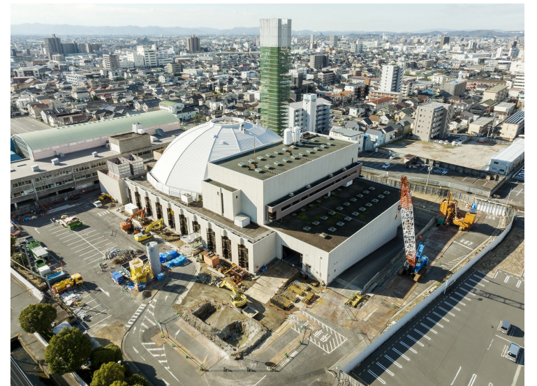
全景写真（北東）
