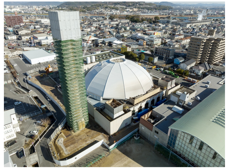
全景写真（南西）
