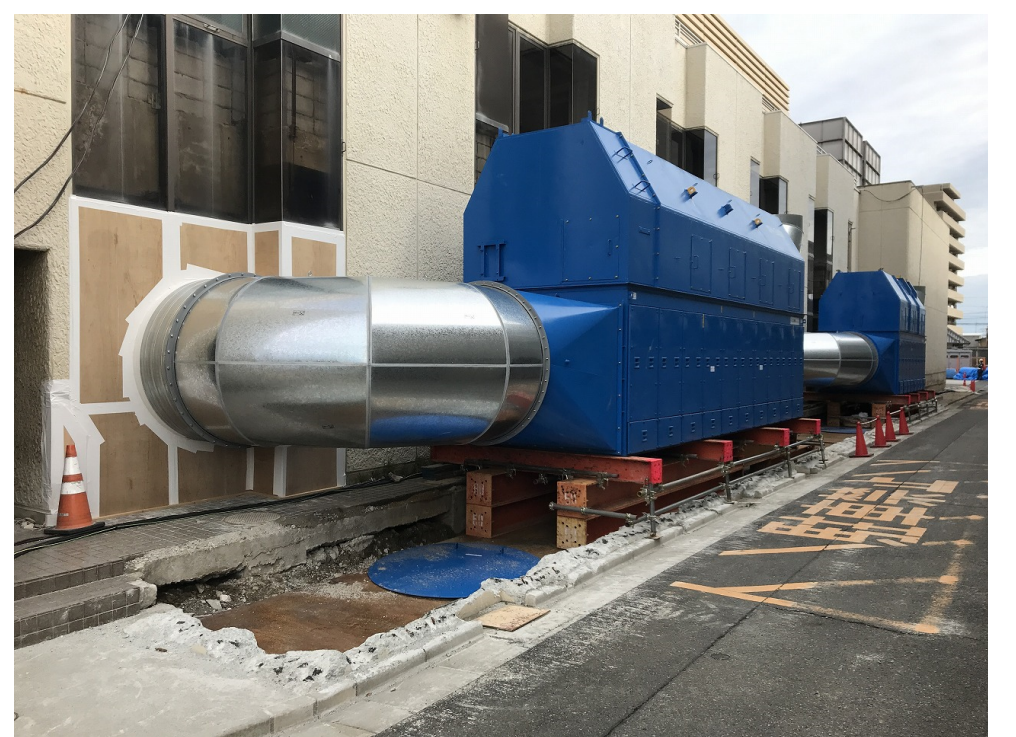
除染工事設備設置
