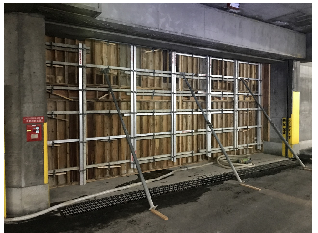
仮設壁施工状況
