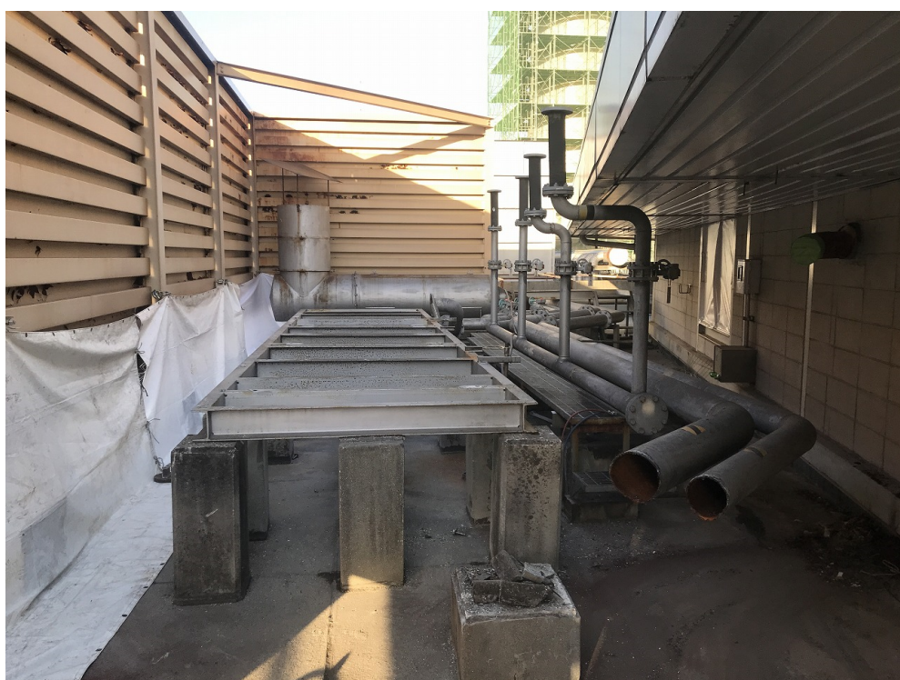
屋上機械撤去
