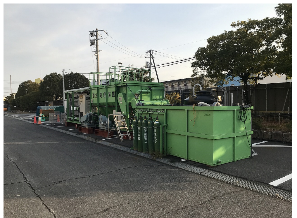
水処理装置設置
