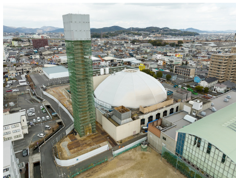
全景写真（南西）
