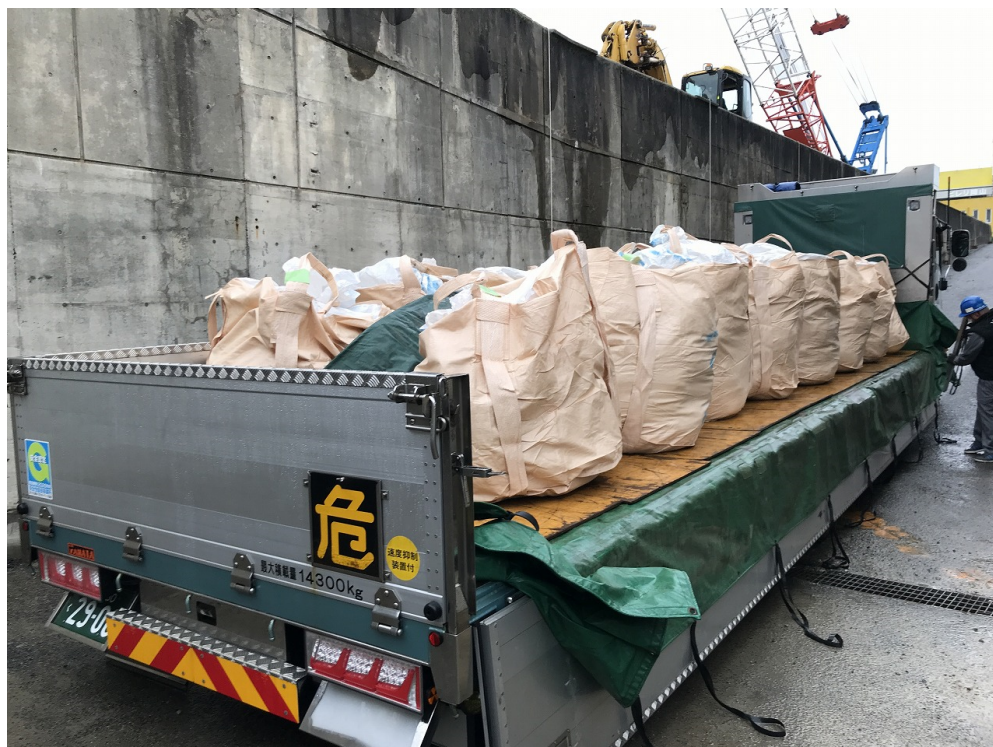
産廃搬出状況
