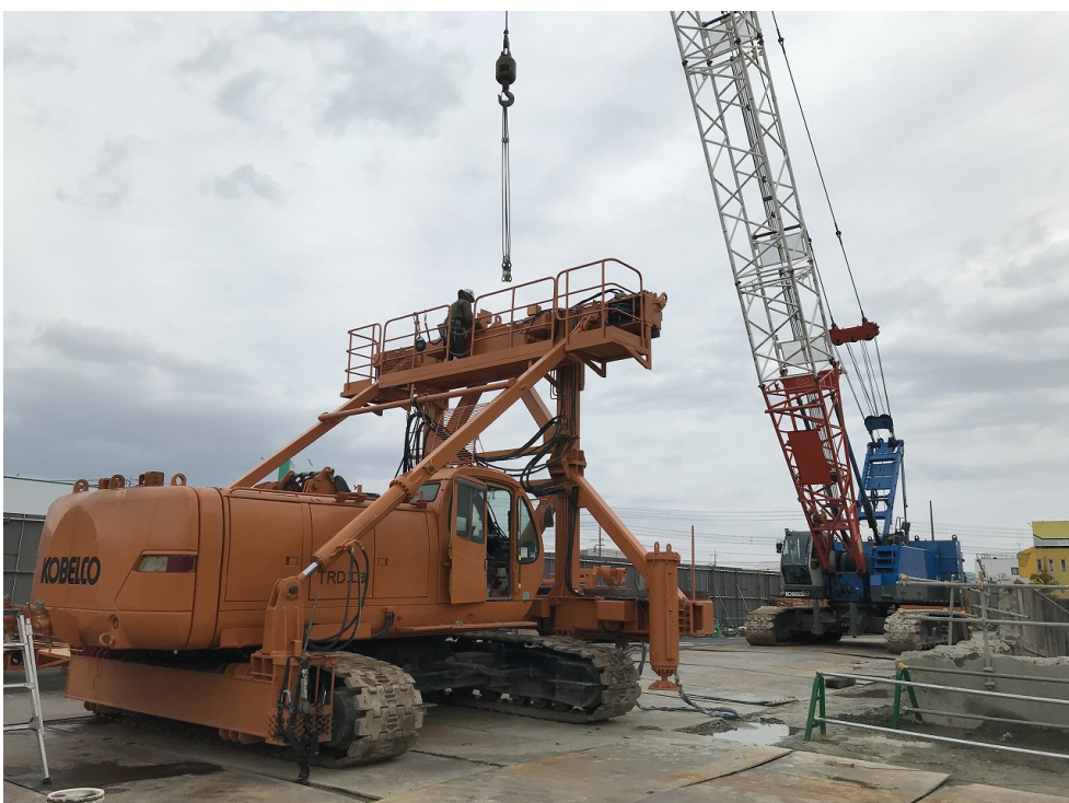
遮水壁 重機解体
