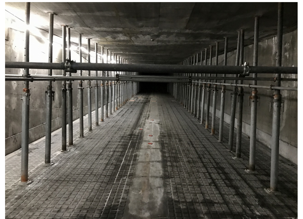
スロープ補強
