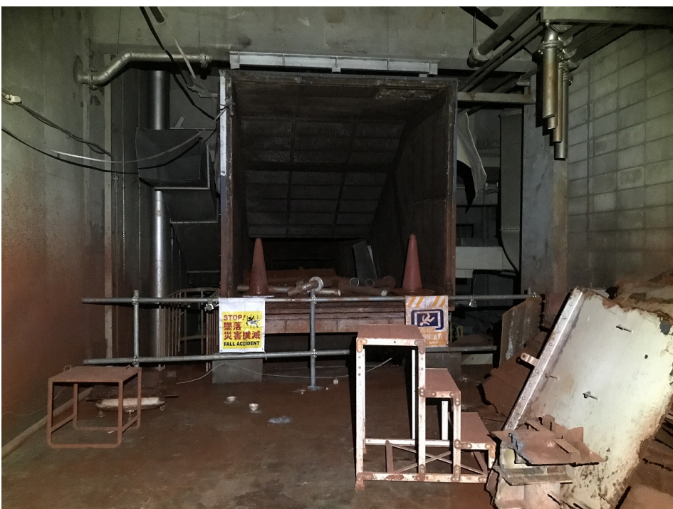
煙道解体状況
