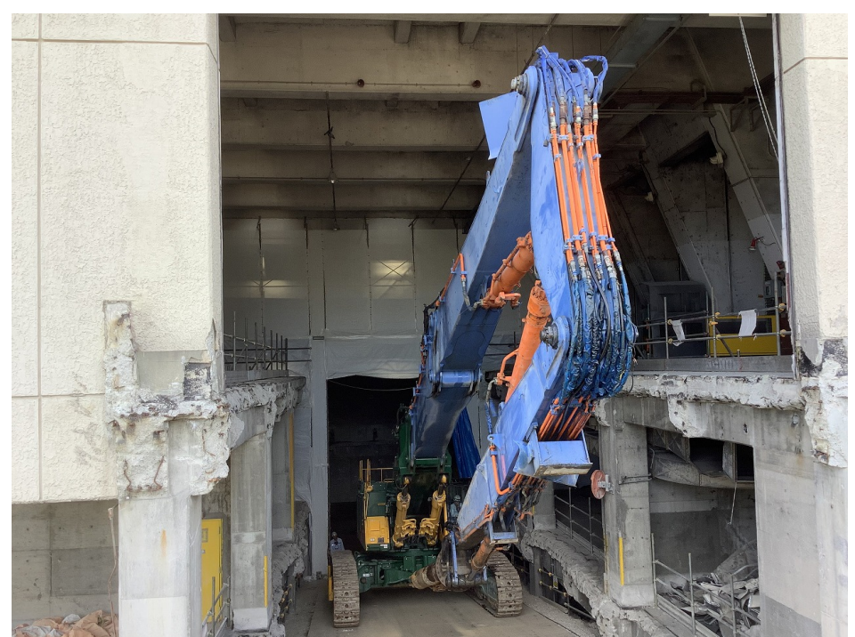
大型重機搬入
