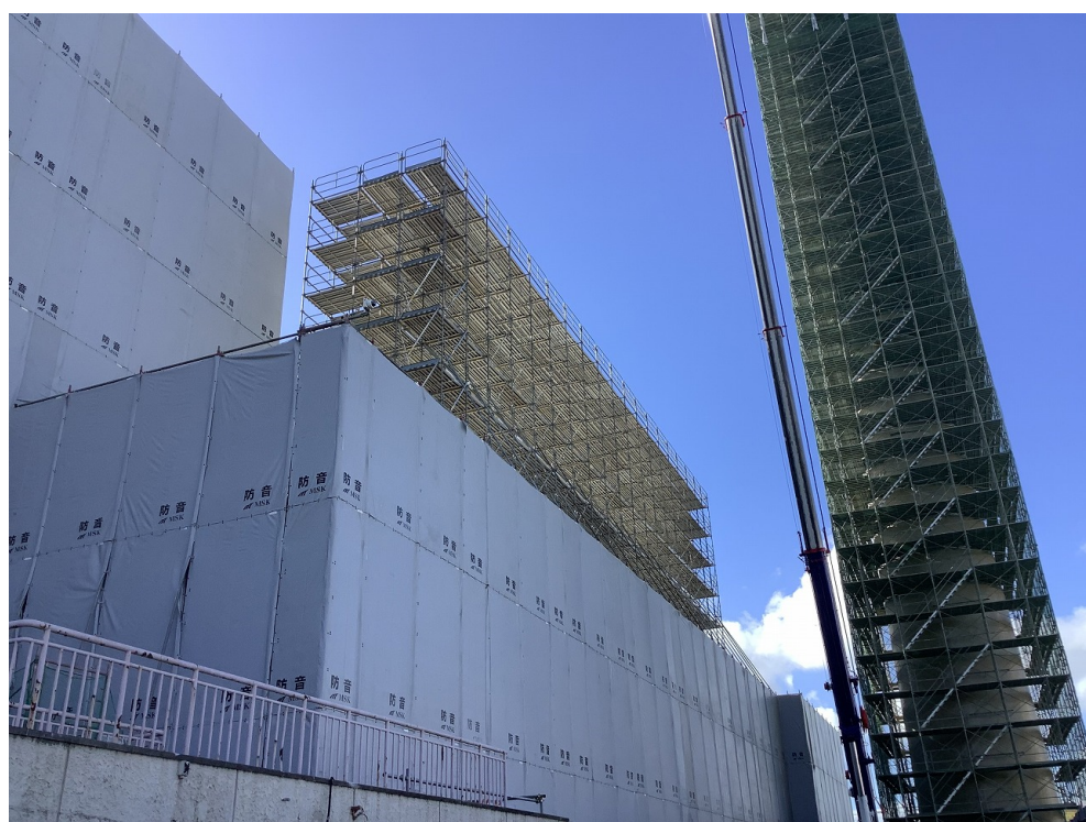
ドーム足場組立
