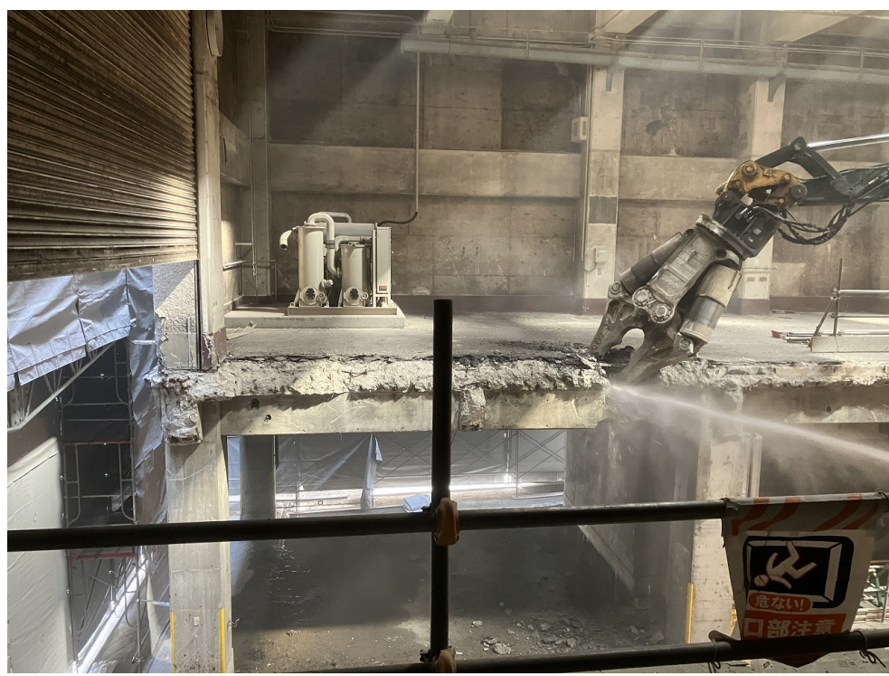
プラットフォーム一部解体
