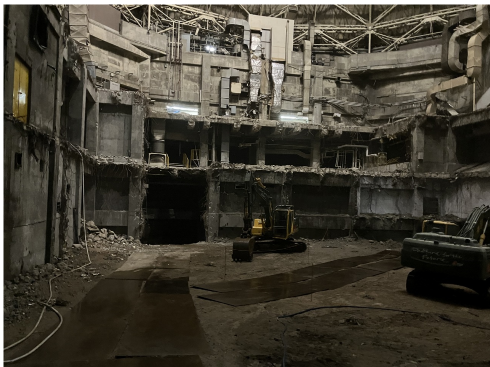
炉室内洗浄完了
