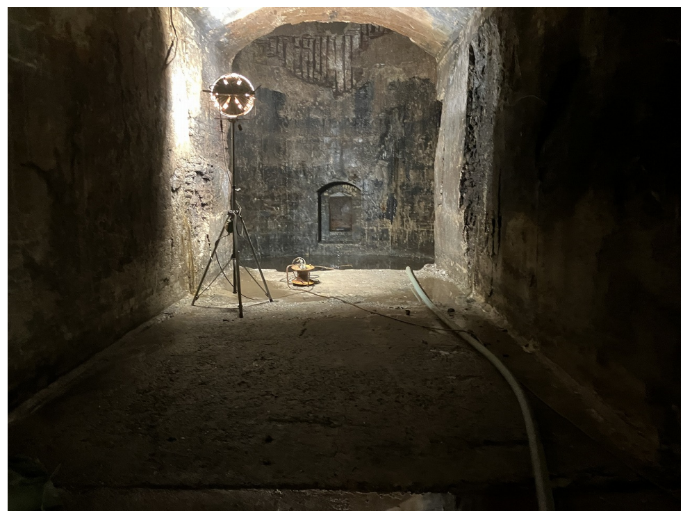
煙突内洗浄完了
