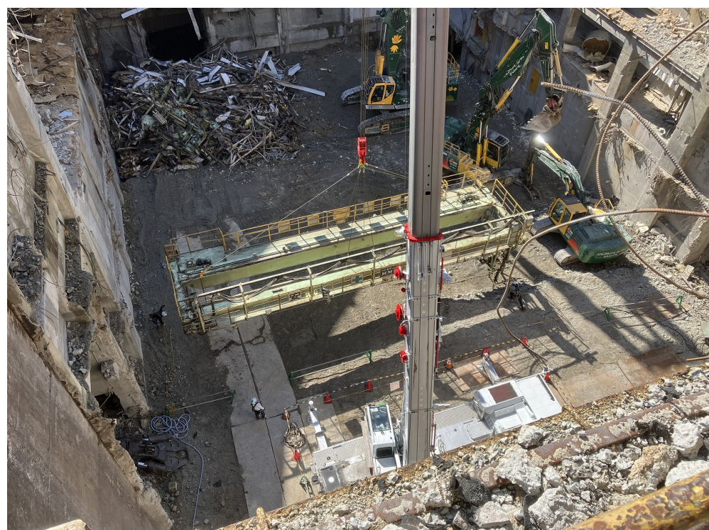
天井クレーン解体状況
