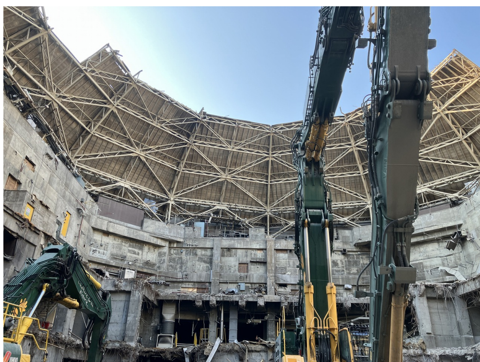
ドーム解体状況
