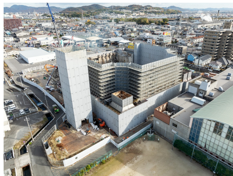
全景写真（南西）
