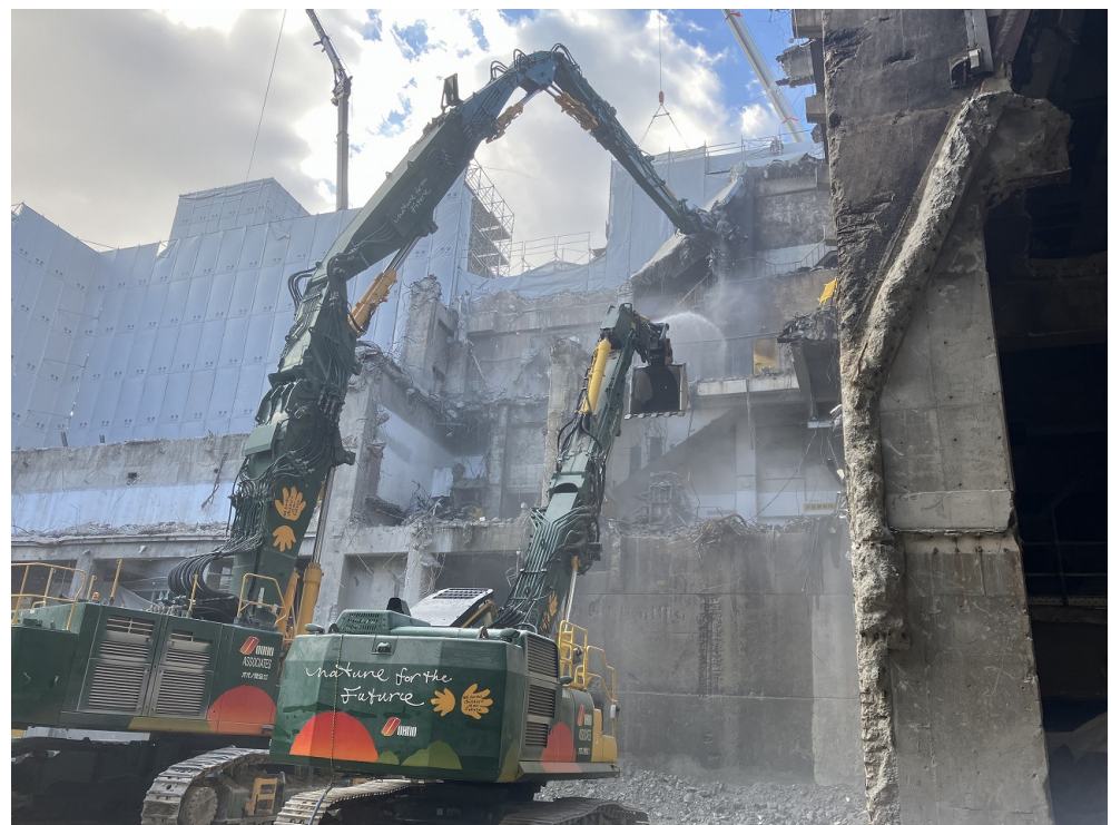
ごみピット解体状況
