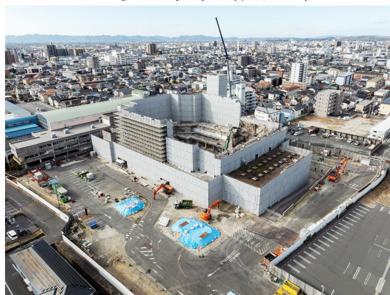
全景写真（北東）
