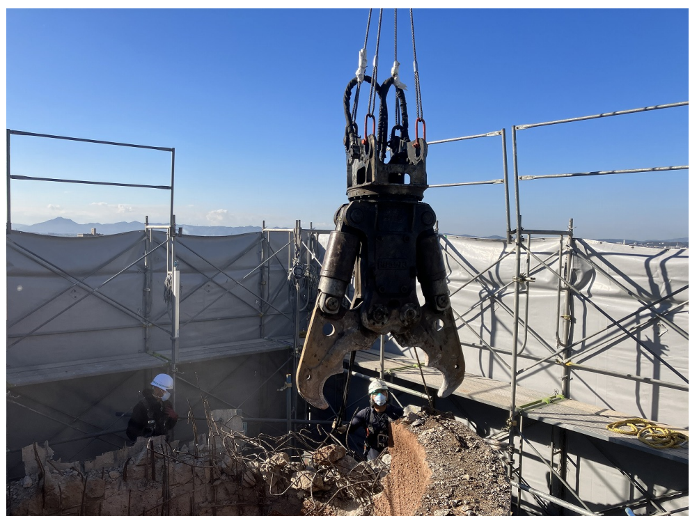
煙突解体状況
