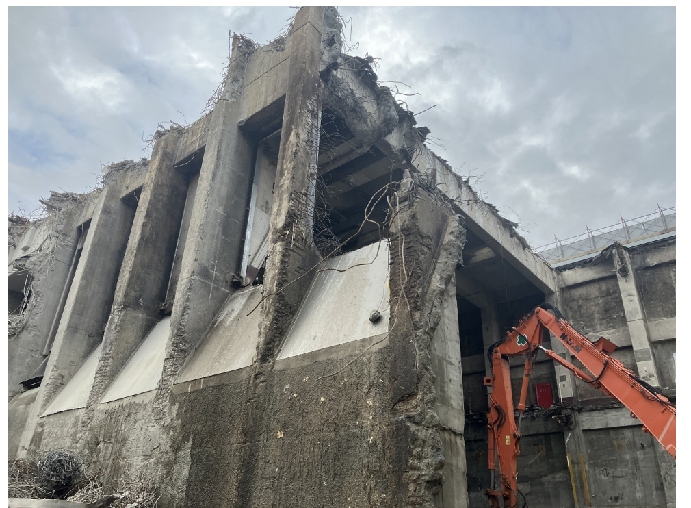
プラットフォーム解体
