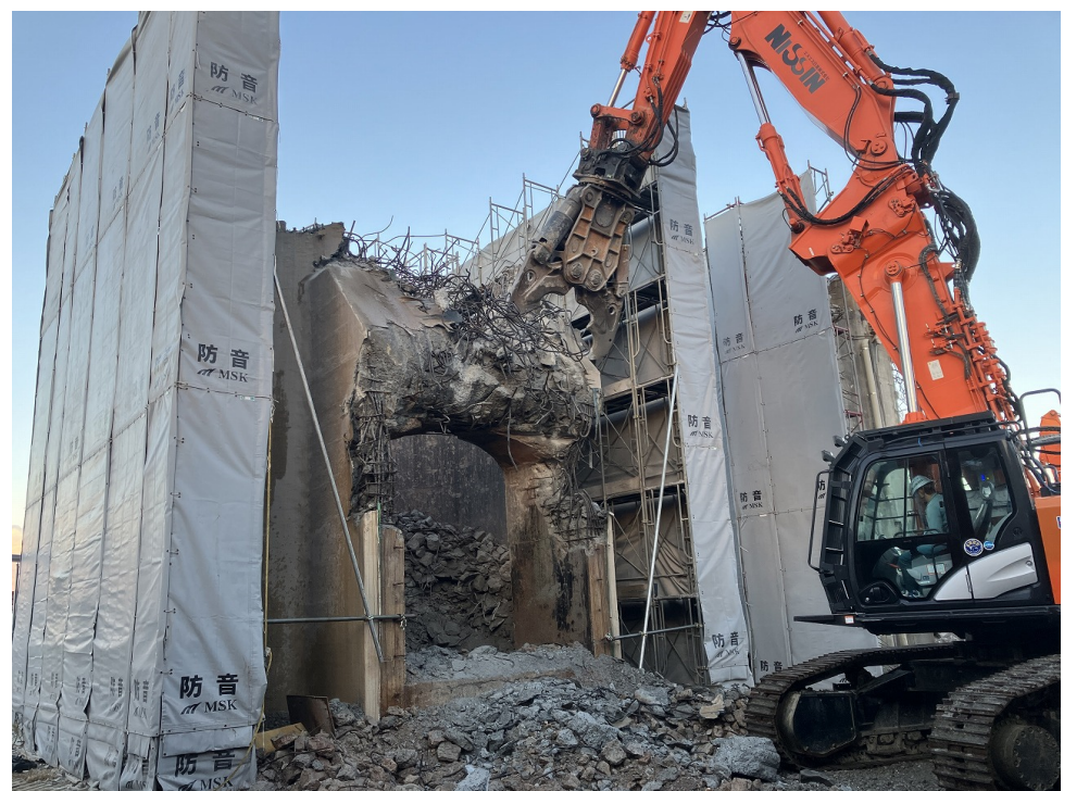
煙突解体（下部）
