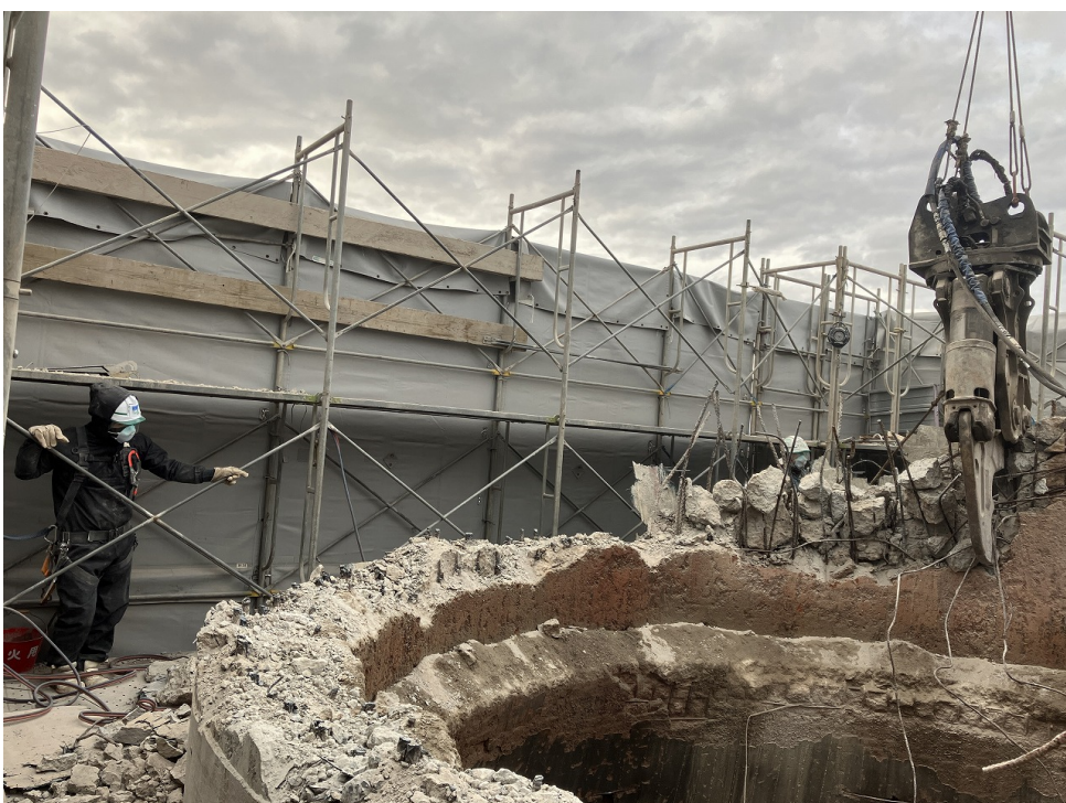
煙突解体（上部）
