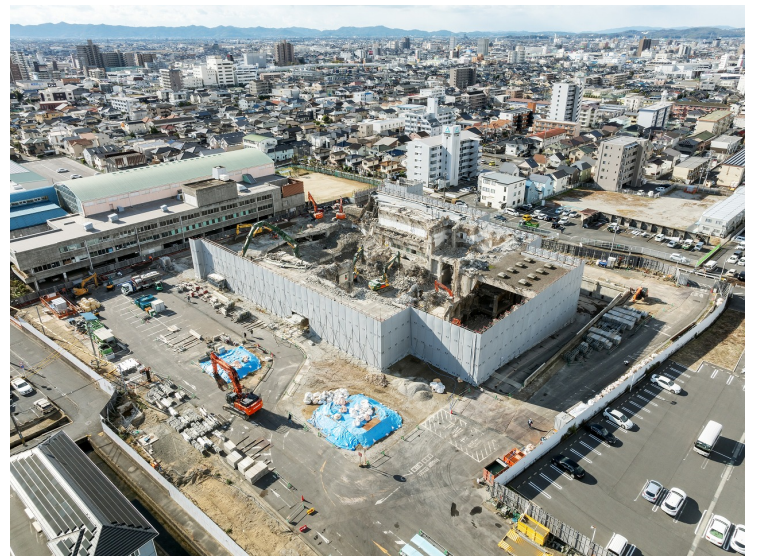
全景写真（北東）
