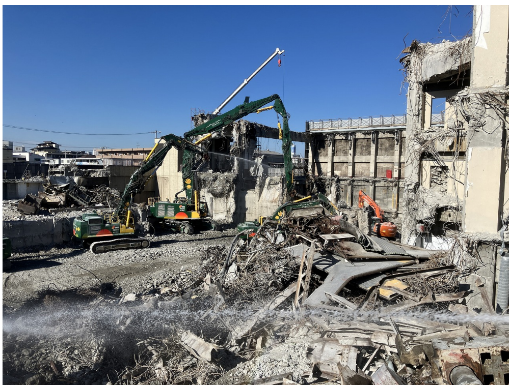
内部上屋解体
