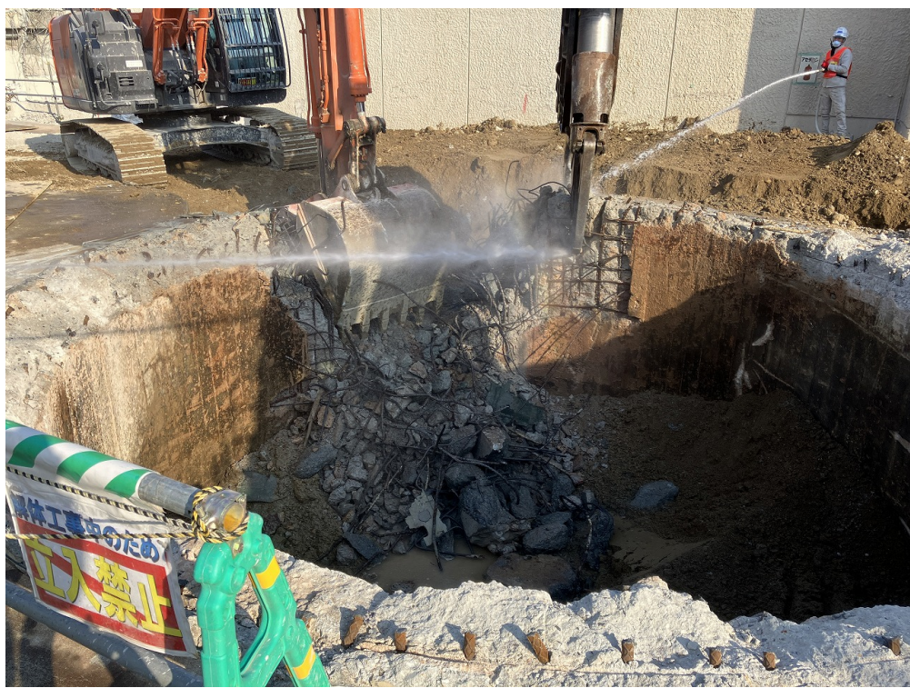
煙突基礎解体
