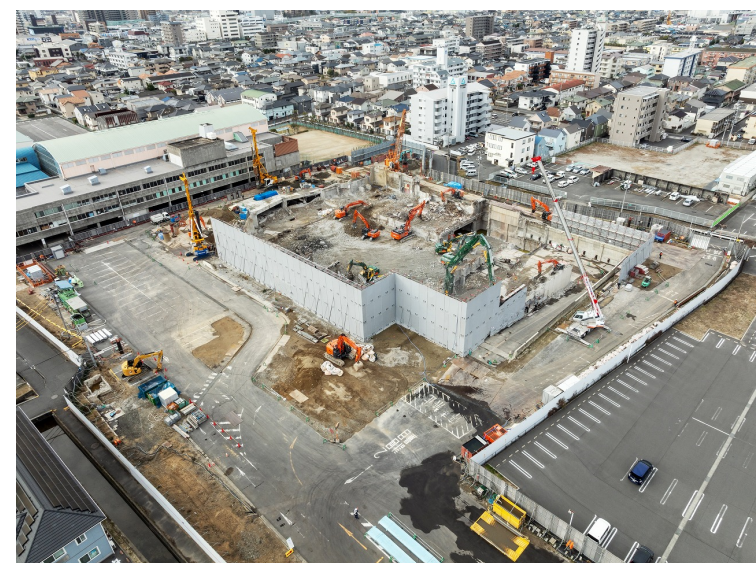
全景写真（北東）
