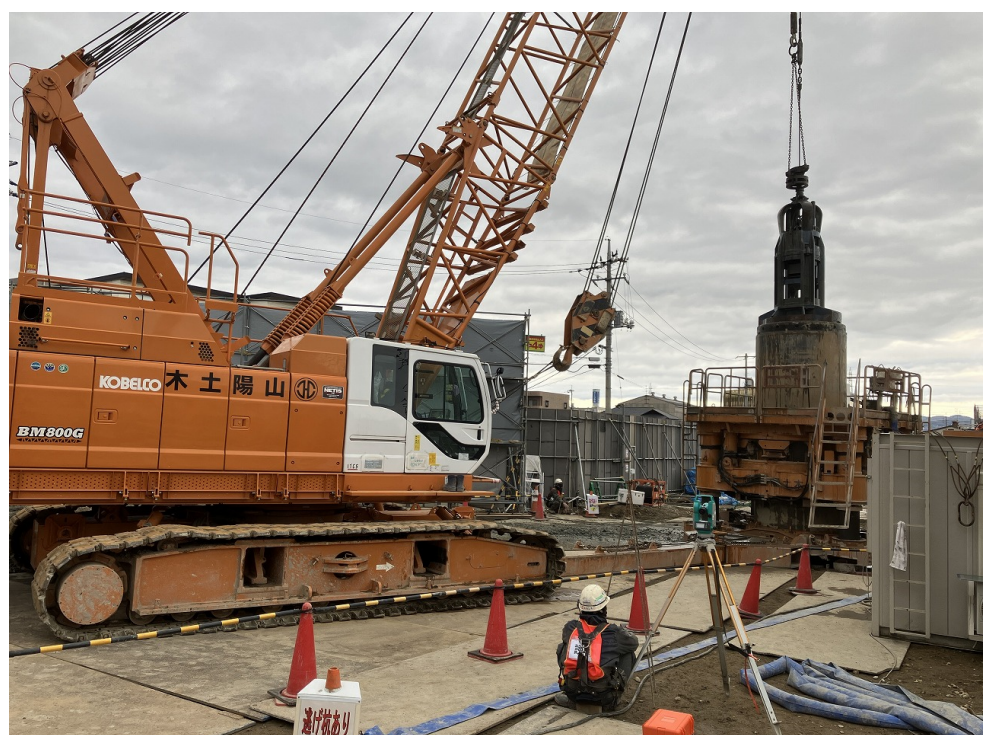
地下躯体撤去（トレンチ）
