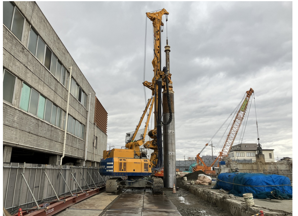
内部上屋解体
