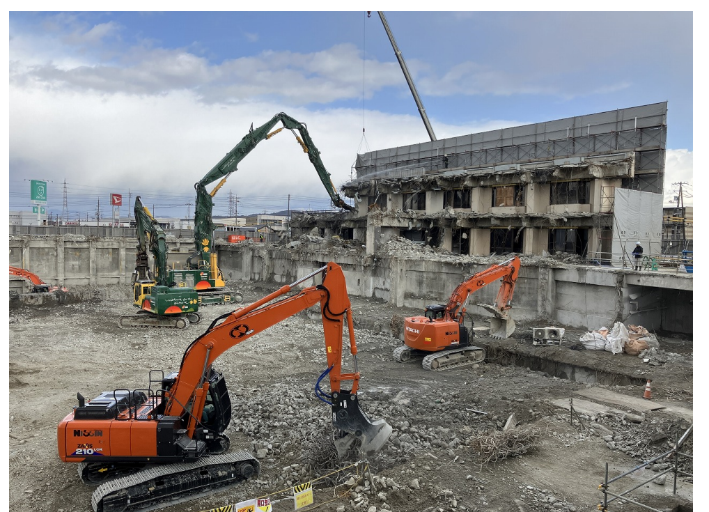
地中障害撤去（南面）
