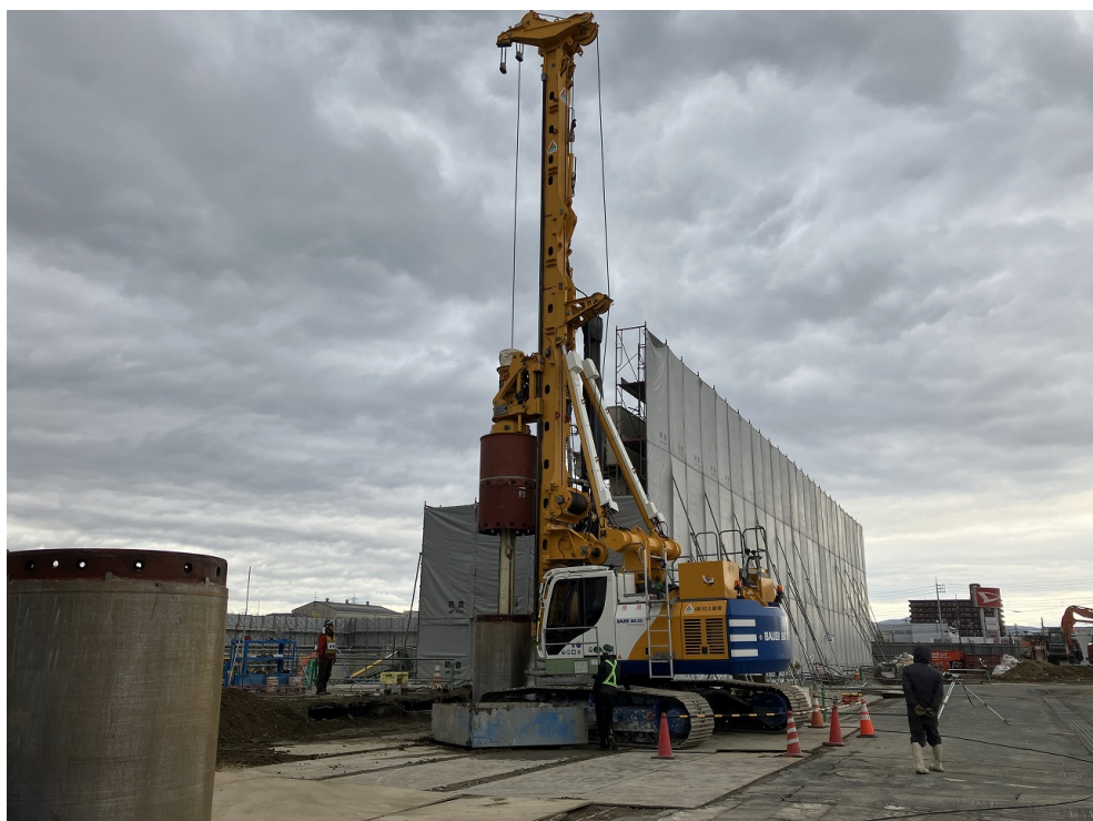
煙突基礎解体
