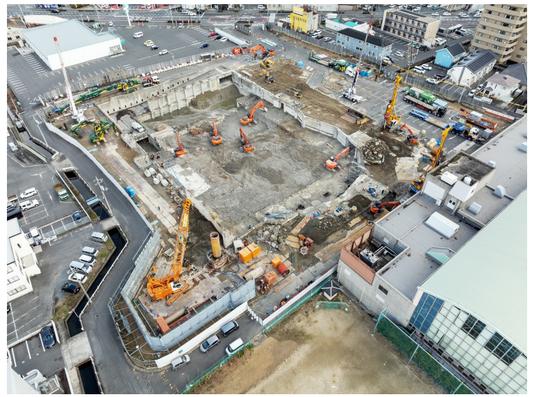
全景写真（南西）
