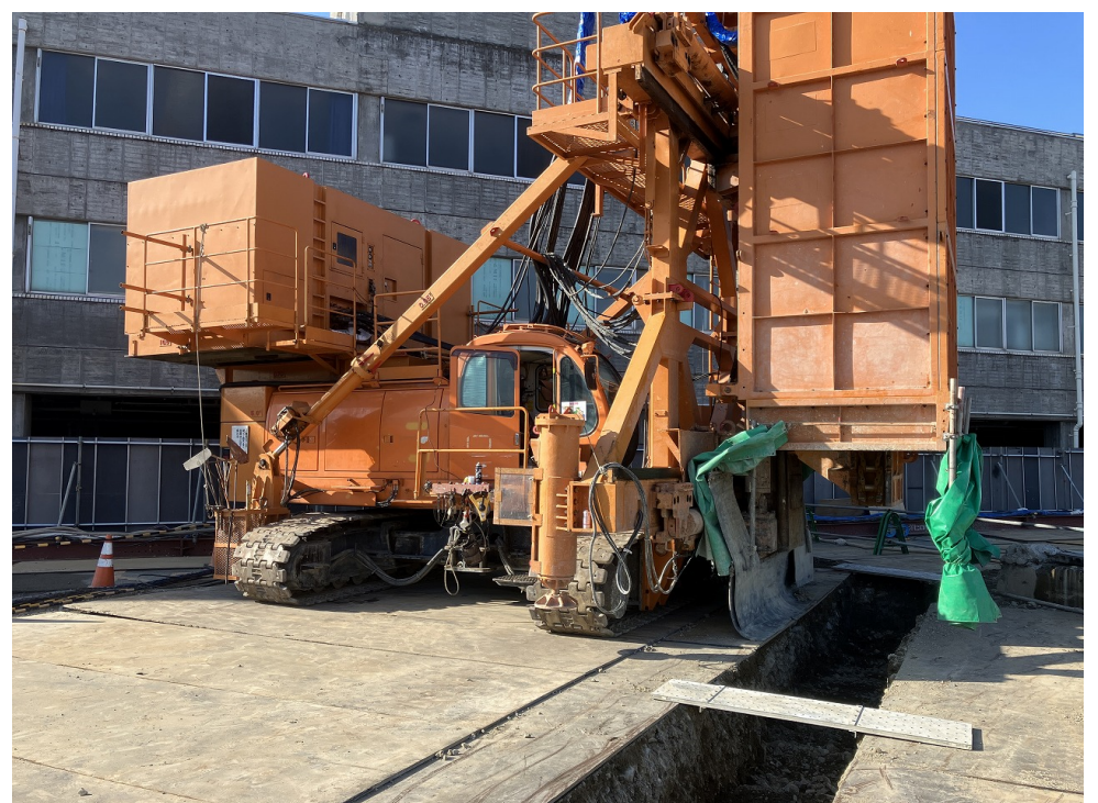
遮水壁（TRD工法）
