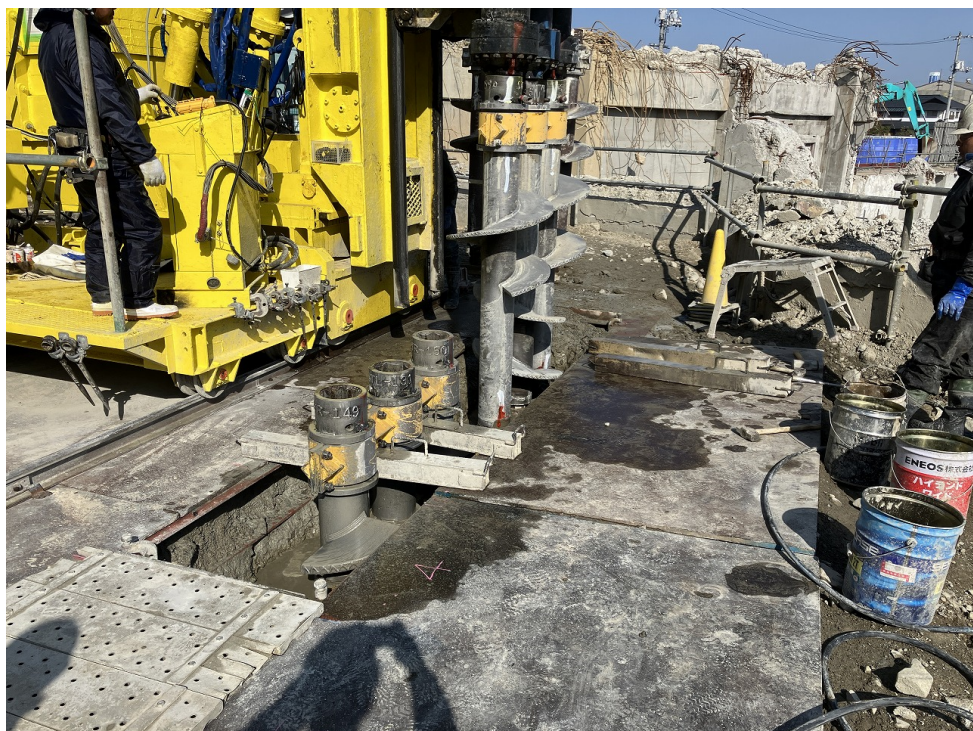
遮水壁（SMW工法）
