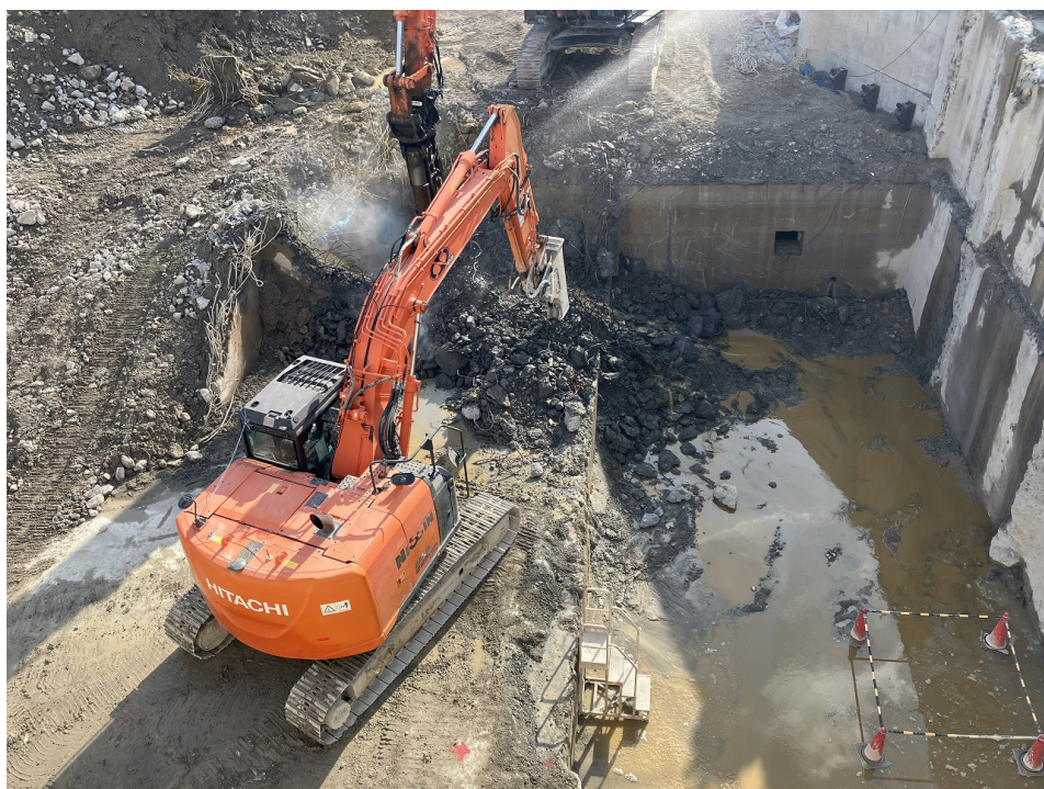
地下躯体解体
