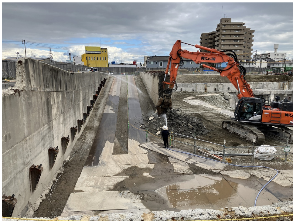
スロープ解体
