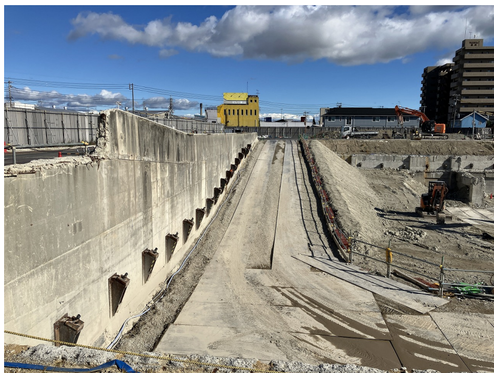
スロープ解体完了
