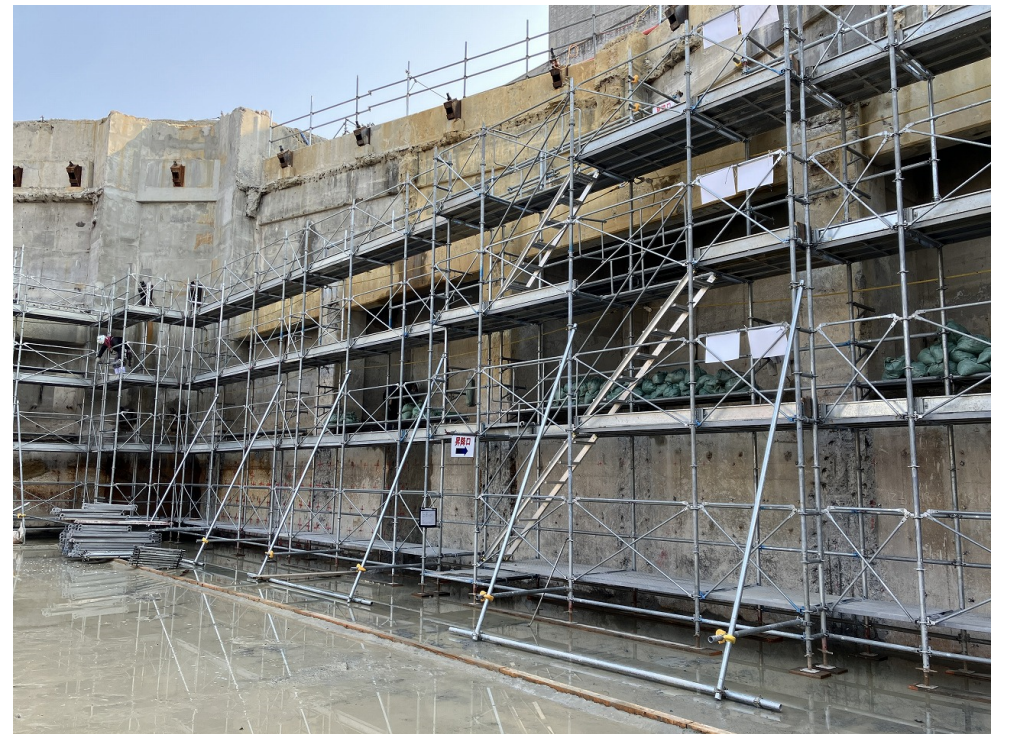
南面足場設置
