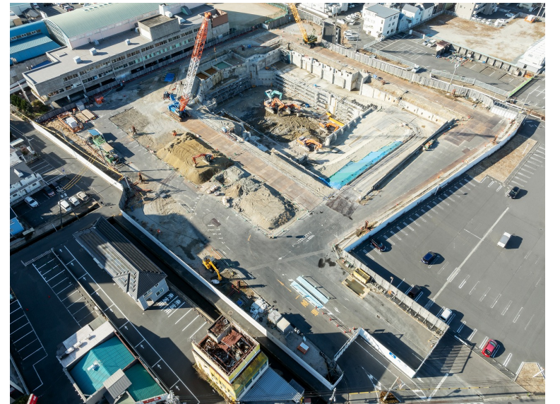
全景写真（北東）
