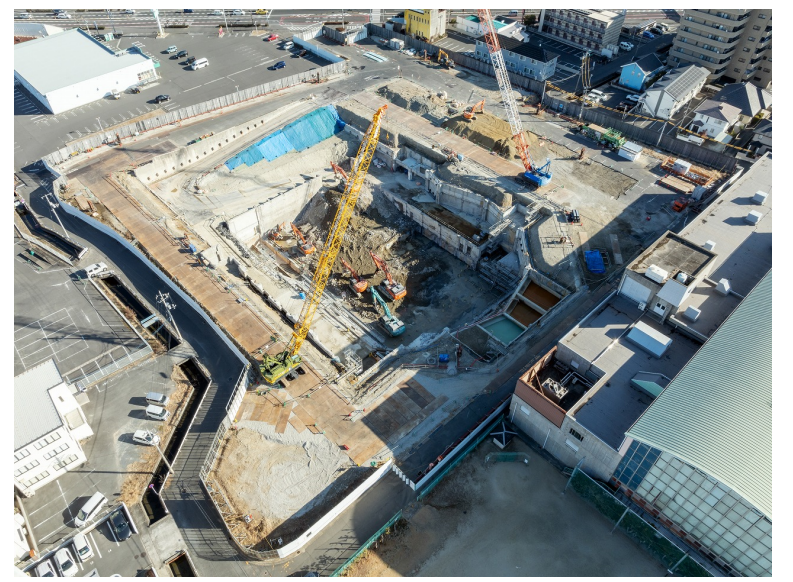
全景写真（南西）
