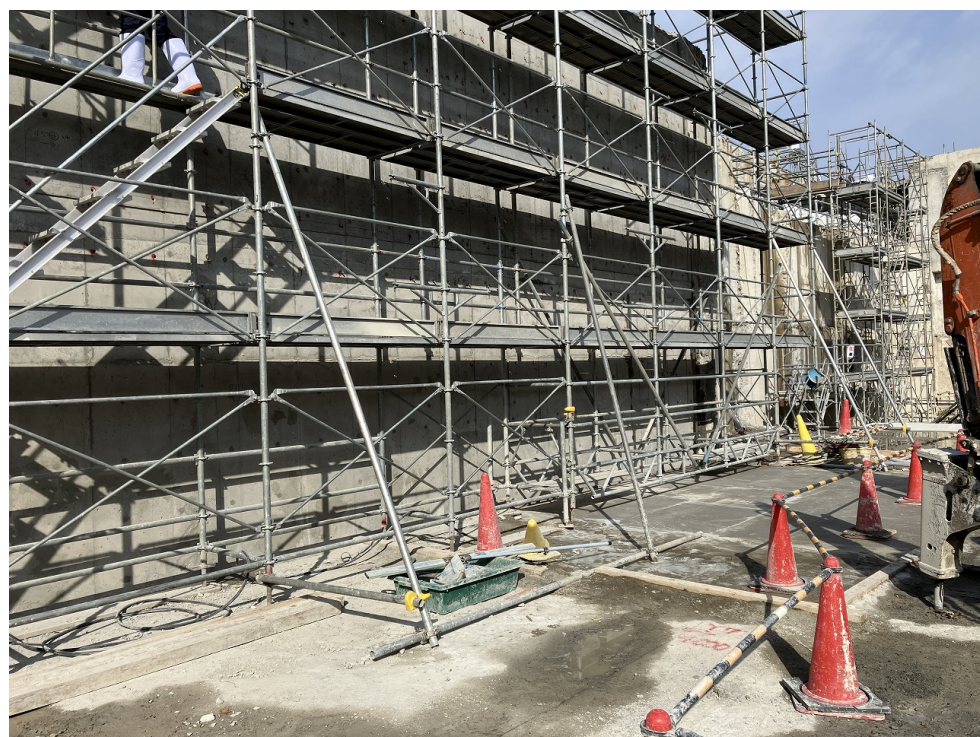
西面仮設壁 出来形
