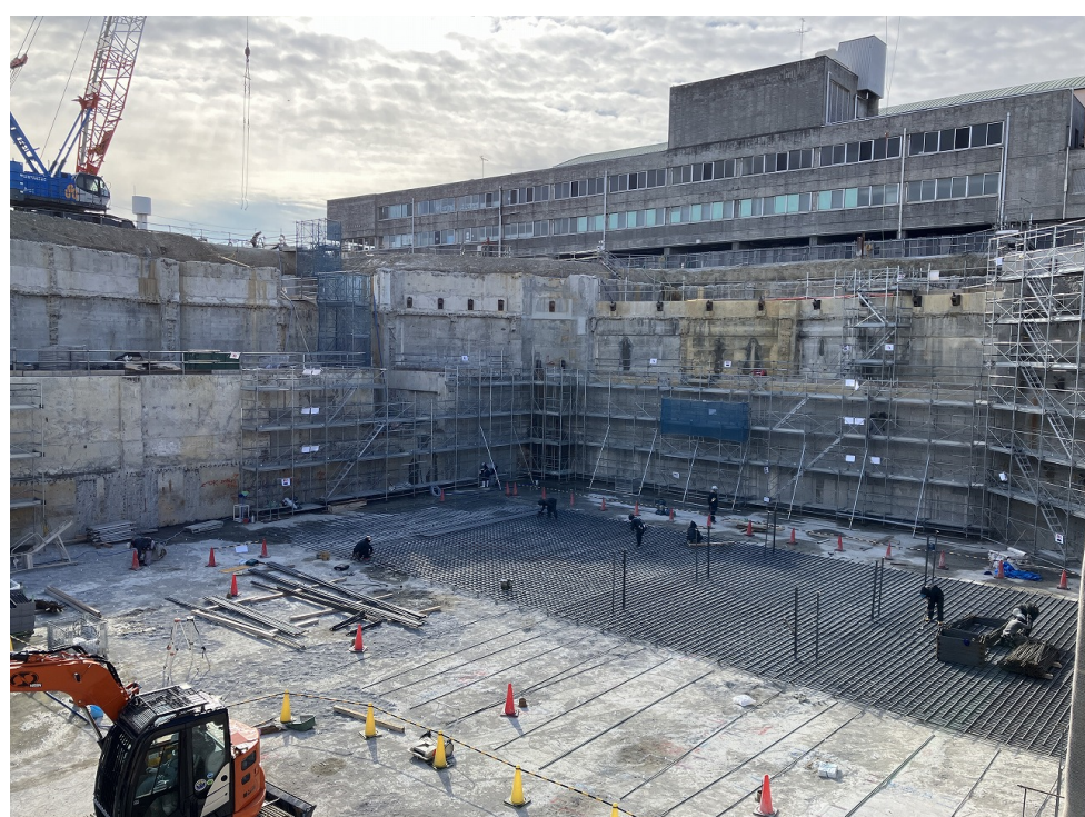
炉室耐圧盤 下筋配筋
