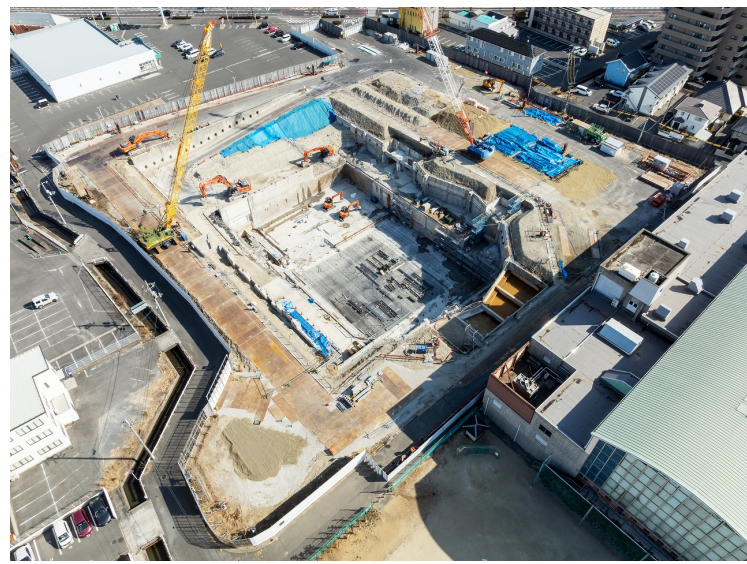
全景写真（南西）
