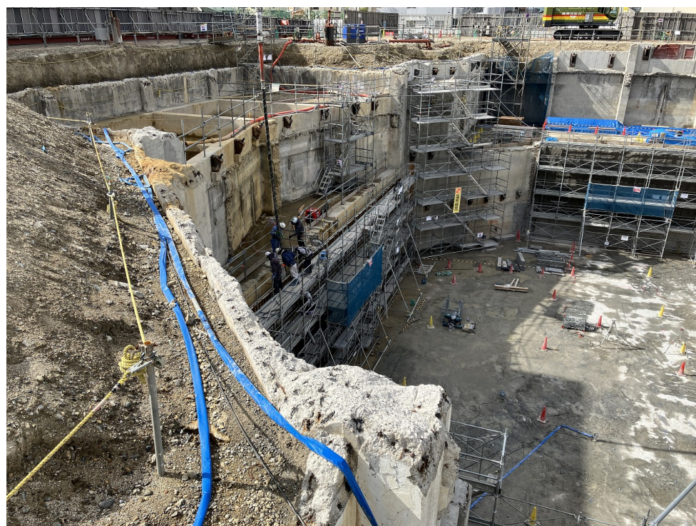
南面仮設壁 CON打設
