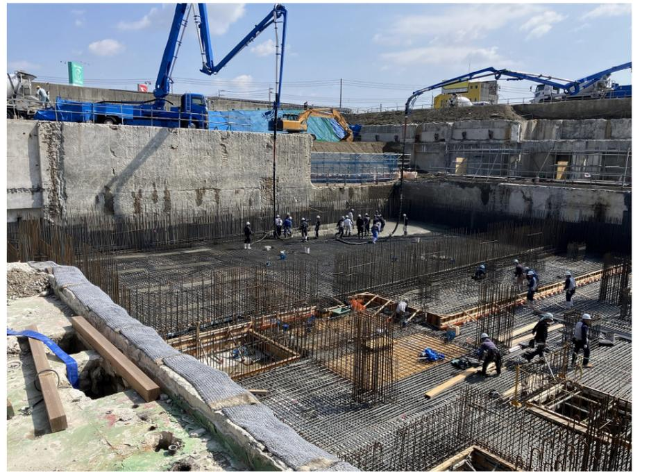
ごみピット耐圧盤 CON打設
