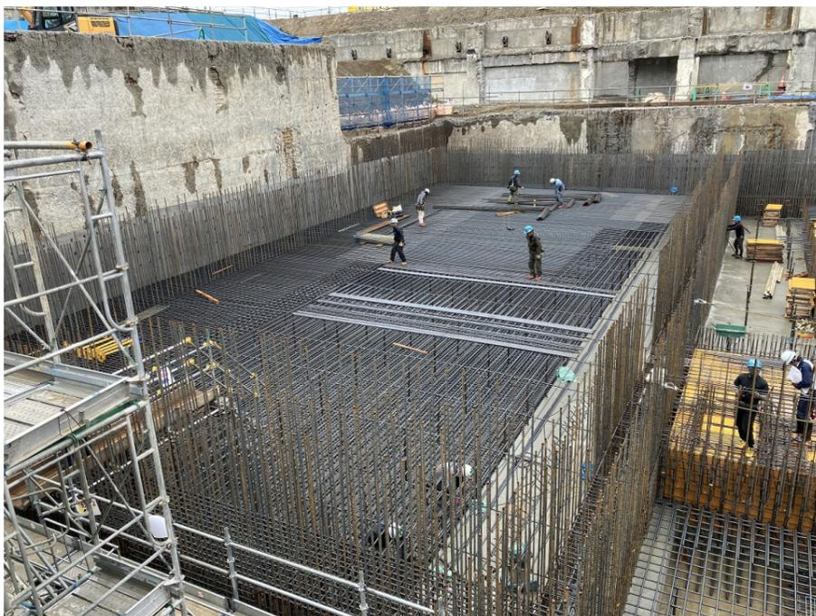
ごみピット耐圧盤 上筋配筋
