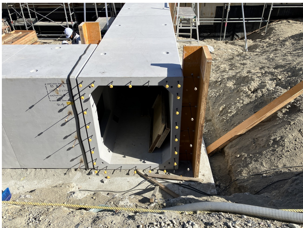
南面 配管ピット設置
