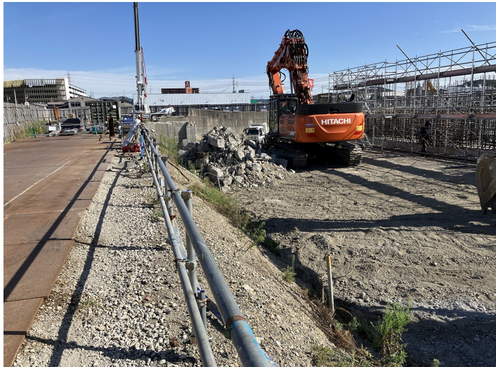
西面 既存躯体解体
