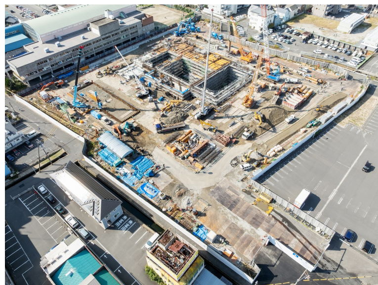
全景写真（北東）
