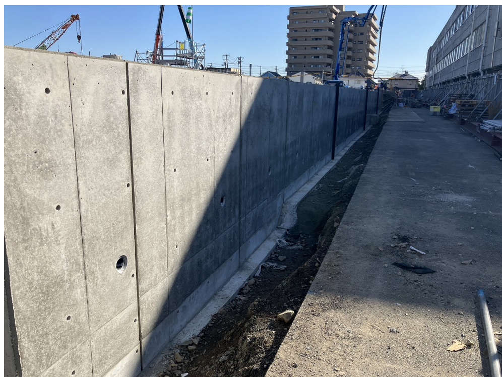
南面 擁壁出来形
