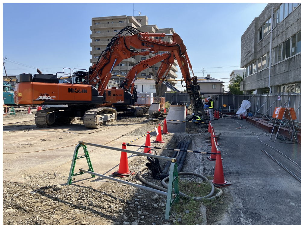
南面 舗装撤去
