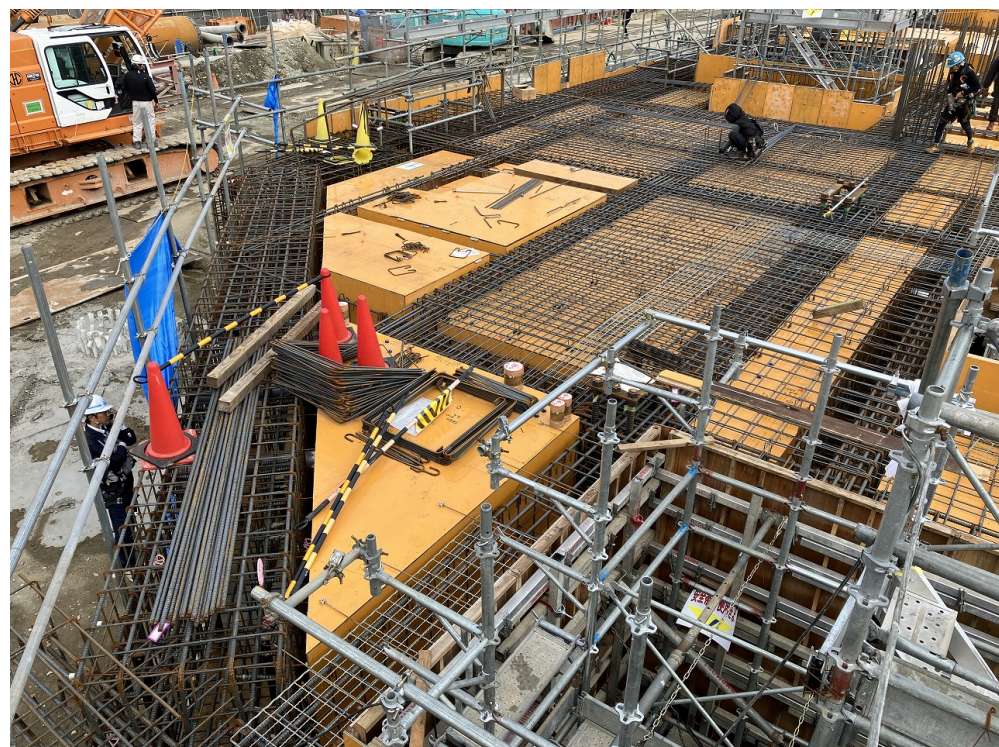
B-①工区 躯体工事
