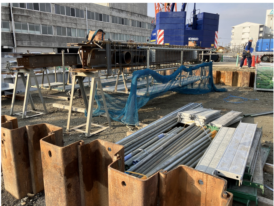
SRC部分先行組立
