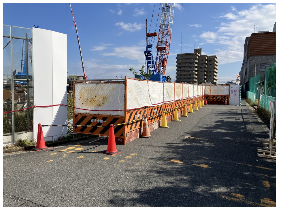
南面 仮囲い拡幅部
