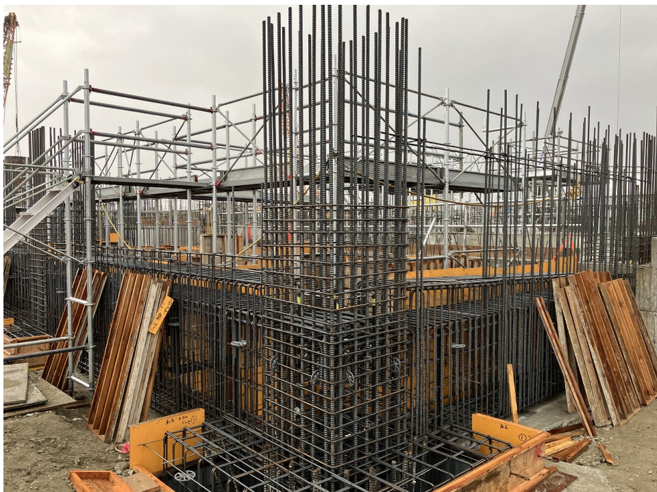
地中梁・基礎工事
