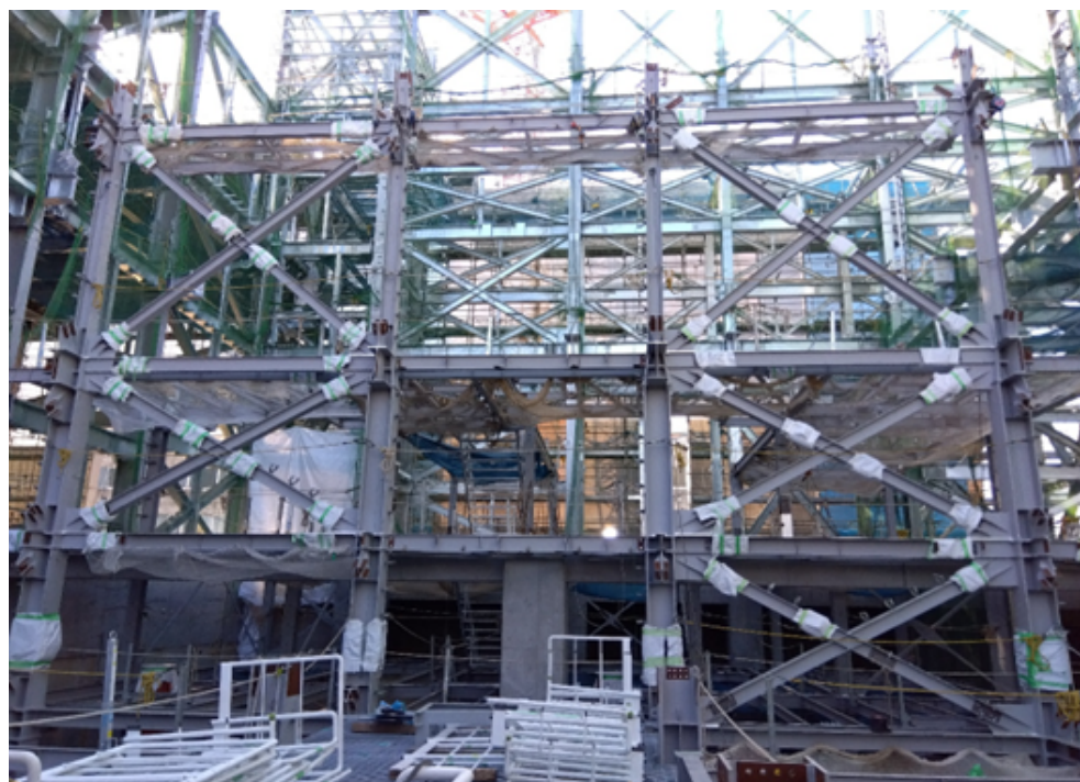
排ガスエリア鉄骨2節建方
