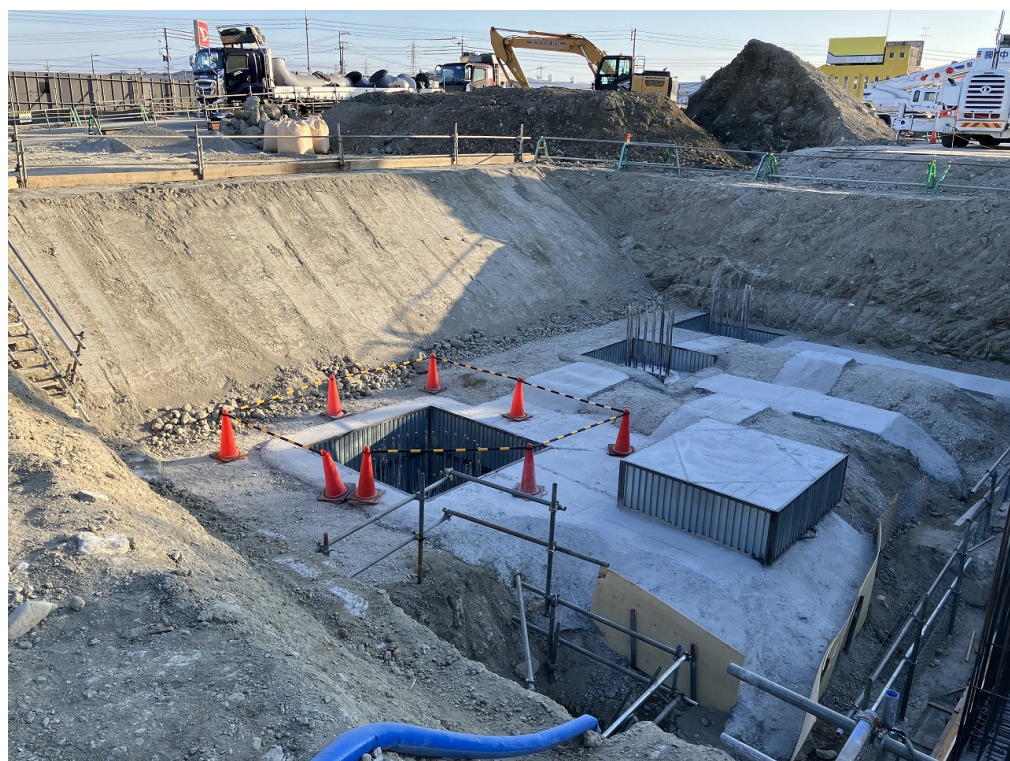
破碎機掘削状況
