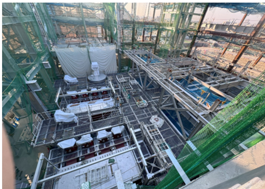
プラント鉄骨全景
