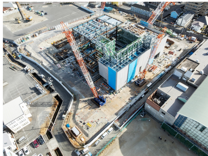
全景写真（南西）
