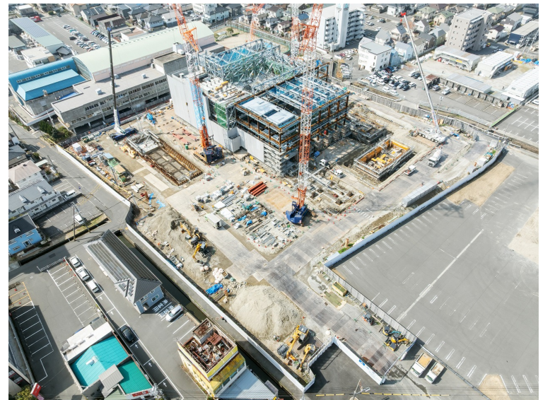
全景写真（北東）
