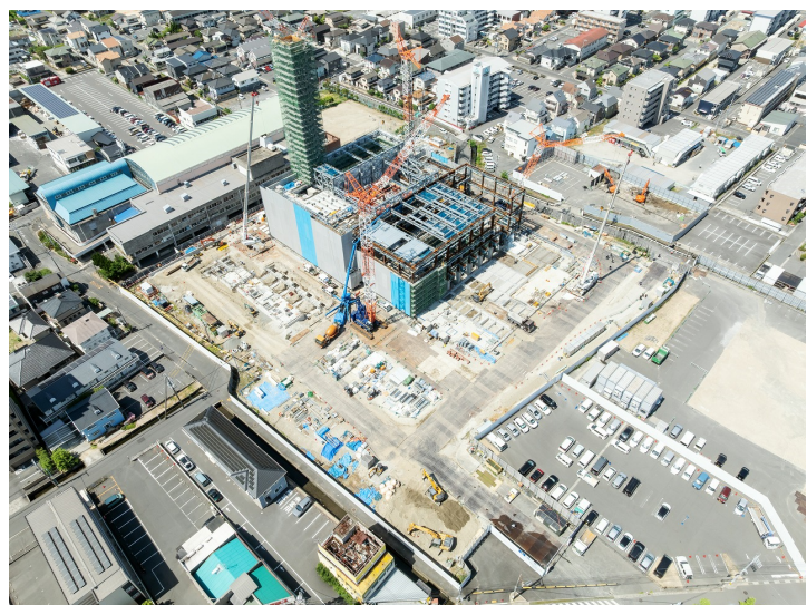
全景写真（北東）
