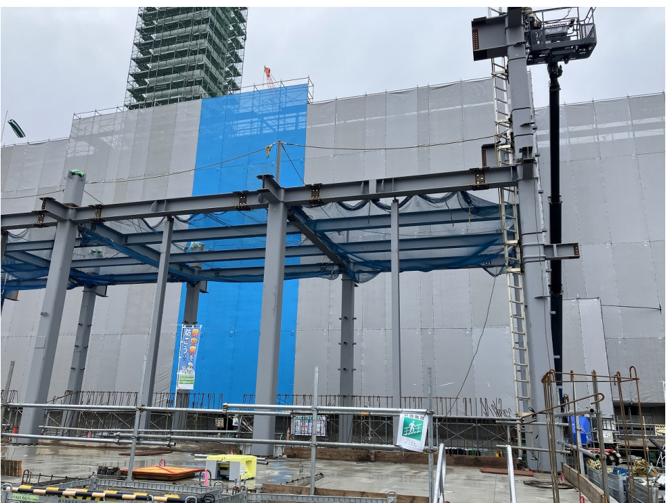
管理棟鉄骨建方
