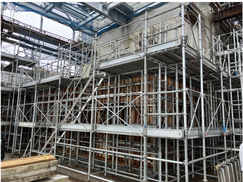
プラットフォーム躯体
