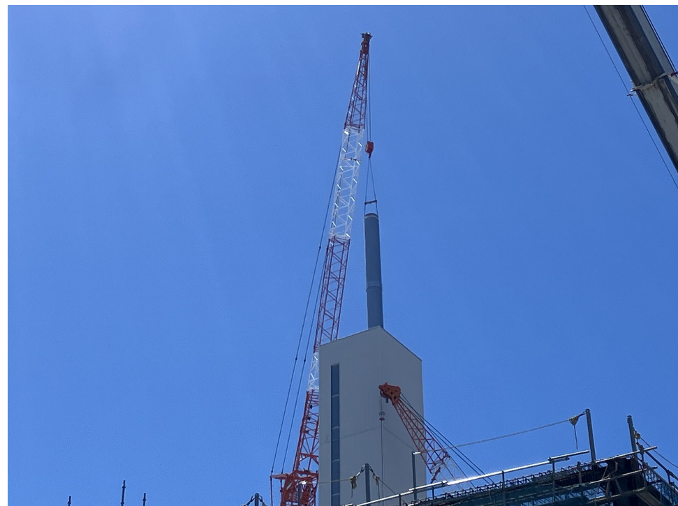
煙突施工状況
