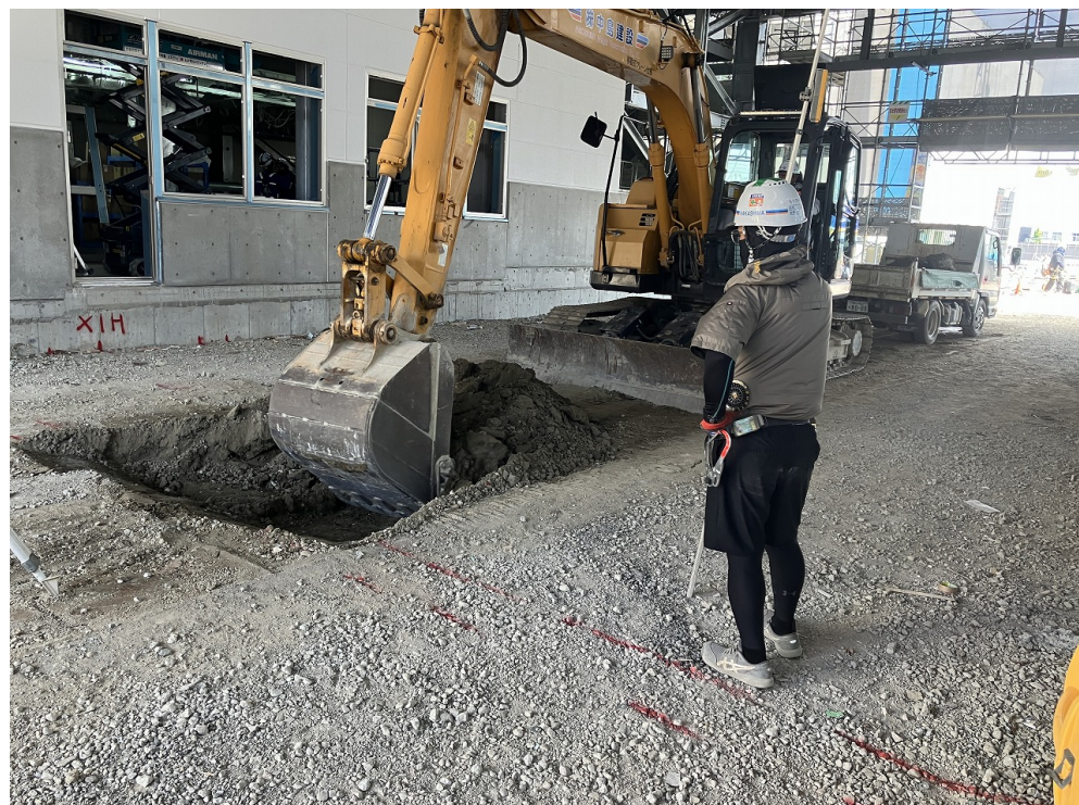
搬入計量棟 施工状況
