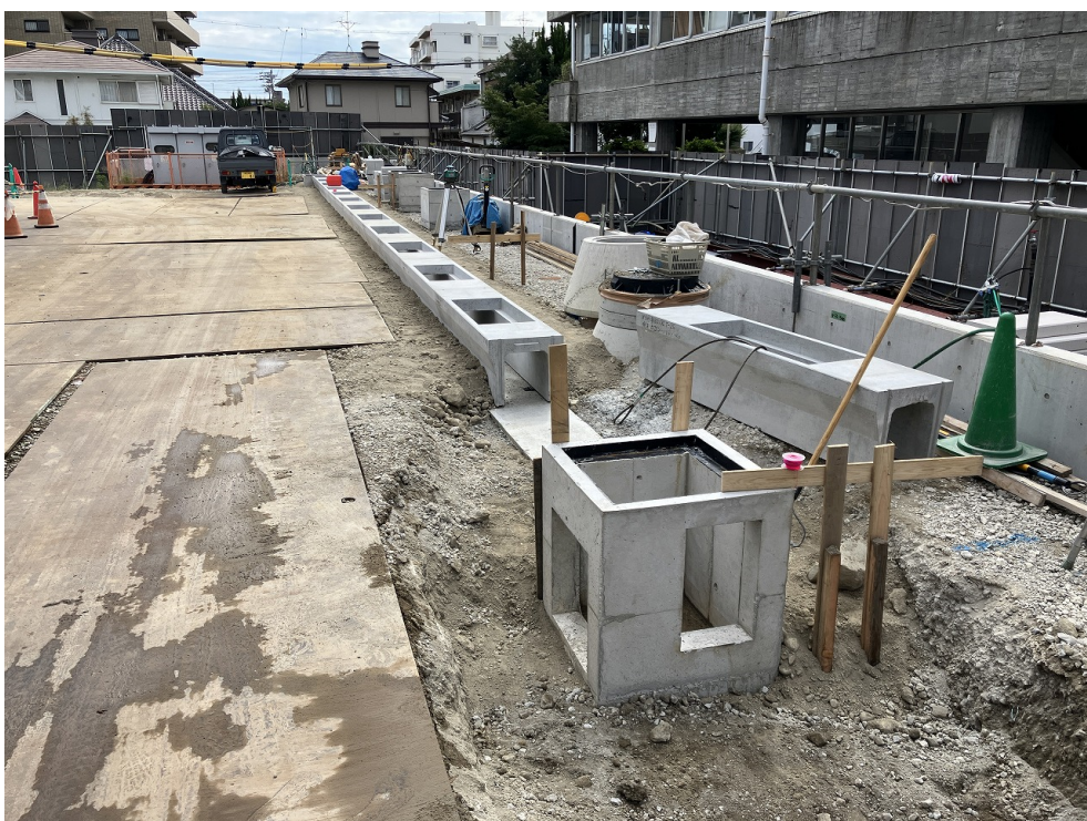
外構 雨水排水側溝 施工状況
